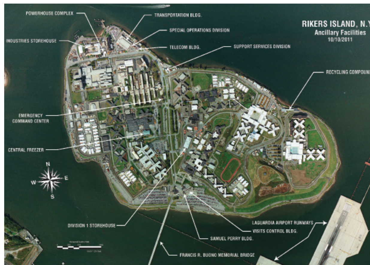
Aerial view of Rikers Island ancillary facilities Vista aérea de las instalaciones auxiliares de Rikers Island
